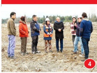
Autoridades inspeccionan encauzamiento en ríos Ancoa y Achibueno
