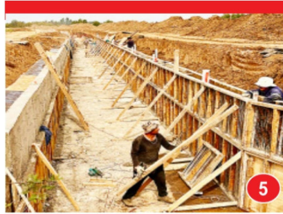
Revestimiento de Canal Unificado Liguay-Bodega alcanza 75% de avance
