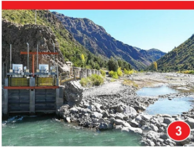
Finalizan obras del sistema de riego Melado en el Maule Sur
