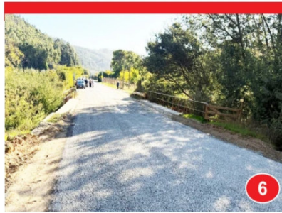
Inicio de pavimentación en sector Piedra del Lobo en Constitución
