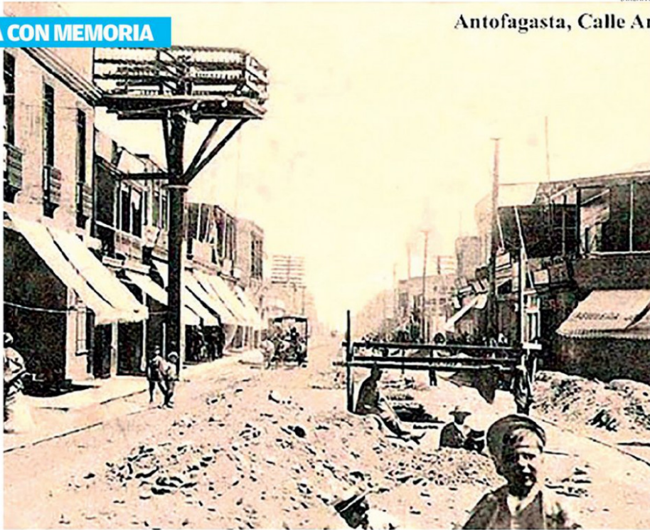
TRABAJOS DE ALCANTARILLADO EN CALLE ANGAMOS (MATTÁ) ESQUINA PRAT EN 1913.
