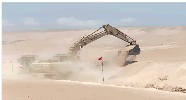
TRABAJO CON MAQUINARIA PESADA.— El Ministerio de Obras Públicas informó que el inicio de los trabajos, junto al paso Chacalluta y el límite internacional con Perú, se concentró entre los hitos 2 y 10.
