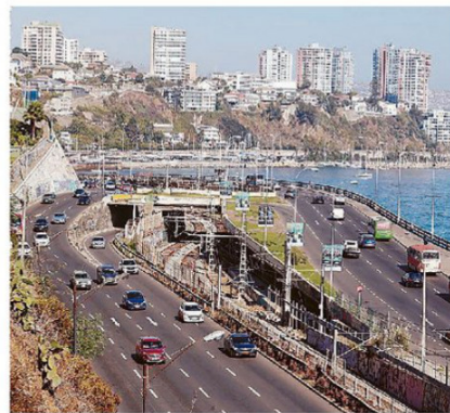
EL VIADUCTO PRESENTA UN AVANZADO DETERIORO ESTRUCTURAL.
