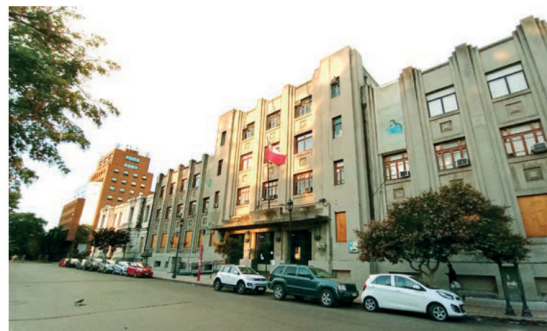
Edificio de servicios públicos.
