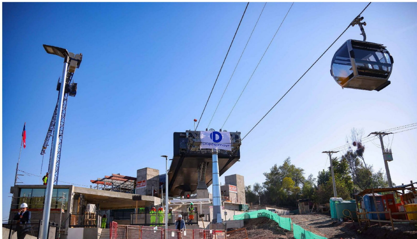
► Actualmente, se están desarrollando pruebas técnicas mediante el traslado de una cabina de pasajeros a lo largo de la línea del Teleférico Bicentenario.
