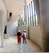
El hormigón fue limpiado y maquinado para darle su aspecto original.
