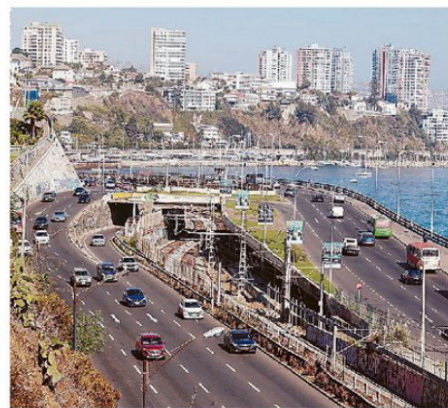
EL VIADUCTO PRESENTA UN AVANZADO DETERIORO ESTRUCTURAL.
