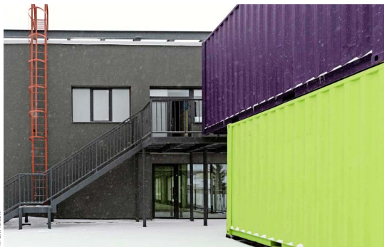
La construcción modular e industrializada permite sortear temas como ubicaciones a gran altitud, ausencia de cadenas de suministro locales y condiciones climáticas que dificultan la ejecución de obras convencionales.
