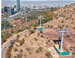
El trazado, que incluye 19 torres, atraviesa el cerro San Cristóbal.
