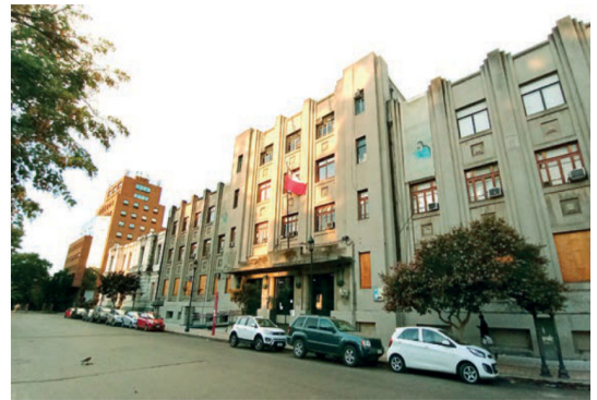
Edificio de servicios públicos.
