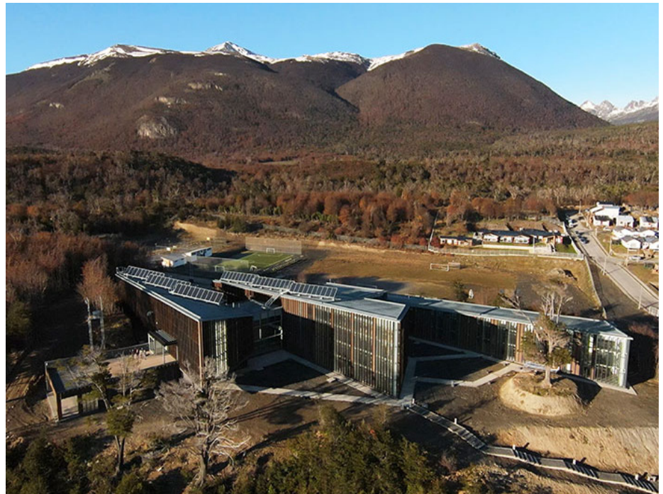
Centro Internación Cabo de Hornos en Puerto Williams.
