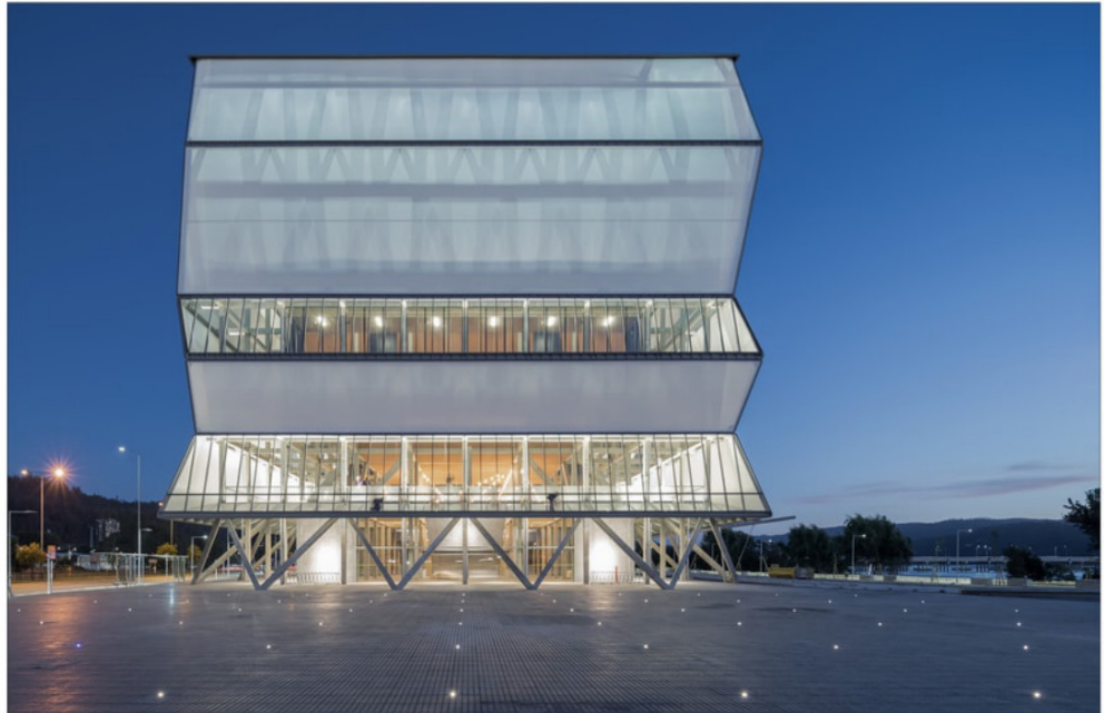
El jurado del premio dijo que con el Teatro Regional, el chileno demuestra que la arquitectura cívica puede lograr presencia sin monumentalidad ni excesos.
