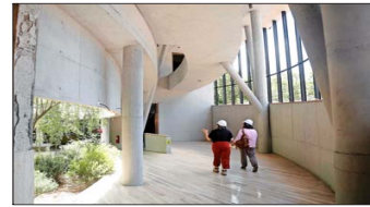
El hormigón fue limpiado y maquillado para darle su aspecto original.
