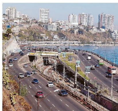
EL VIADUCTO PRESENTA UN AVANZADO DETERIORO ESTRUCTURAL.
