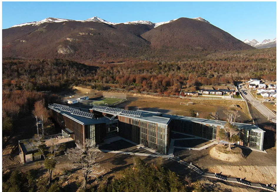
Centro Internación Cabo de Hornos en Puerto Williams.
