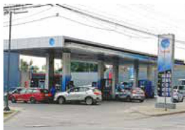
Recintos afectados siguieron funcionando sin problemas.
