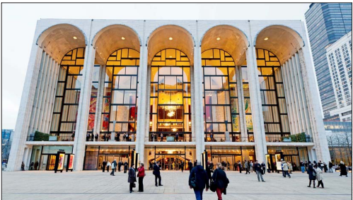
A través de la fachada vidriada del MET se vislumbran los murales de Chagall, a la extrema izquierda y derecha.
