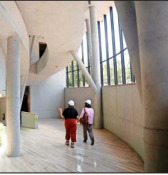
El hormigón fue limpiado y maquinado para darle su aspecto original.
