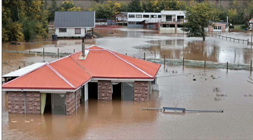
Inundaciones. Frente a los impactos del cambio climático, debido a lluvias intensas en corto tiempo, piden que el Presidente Kast anuncie inversiones en investigación, prevención e infraestructura.
